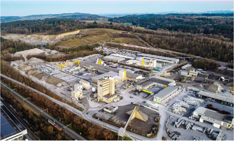
Das Kies- und Betonwerk von Vigier Beton heute: Seit 1871 wird in Lyss Kies abgebaut.
