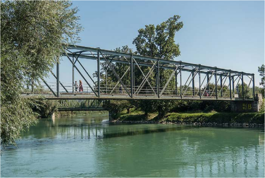
Über den Hagneckkanal bei Walperswil: Die Brücke stammt aus der Zeit der 1. Juragewässerkorrektion. Sie wurde in der damals werkseigenen Schlosserei in Nidau vorgefertigt.
