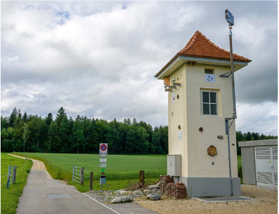
Der Trafoturm und seine Umgebung in der Hardern bietet Unterschlupf für Zwei- und Vierbeiner.
