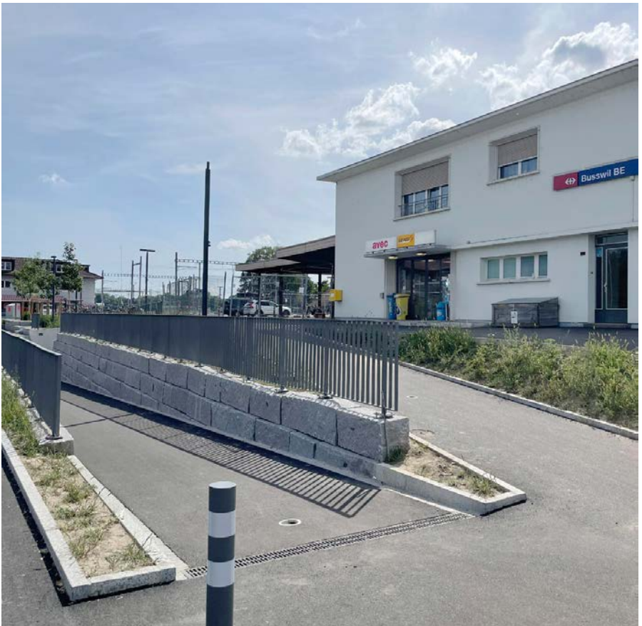
Hindernisfrei zur Bahn
