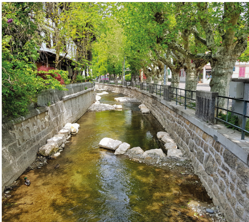
Der Lyssbach mit Betonbrüstungen nach der Sanierung
