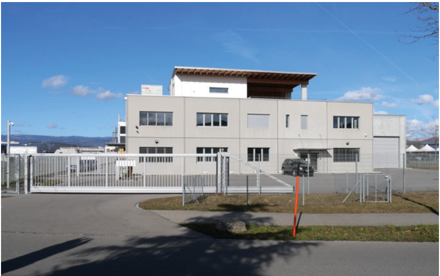
Gut gesichert: Firmengebäude von Metalor
