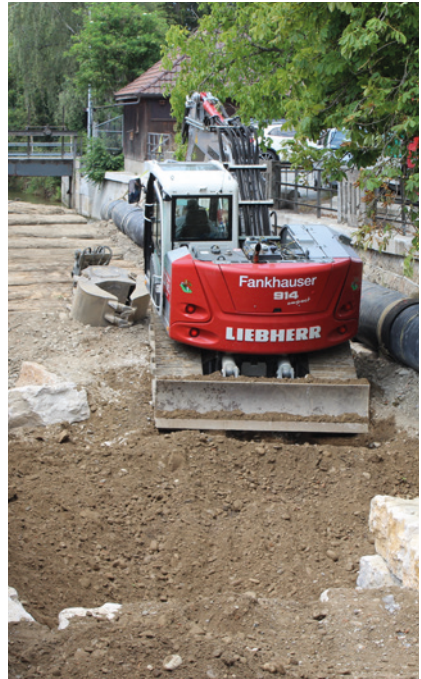
Lyssbach, Ausbau altes Gerinne, 2. Etappe (2020)
