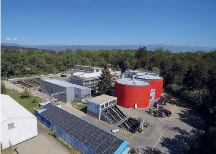
Abwasserreinigungsanlage in Lyss
