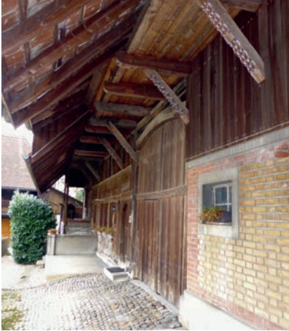
Nordfassade des Bauernhauses mit geschnitzten und bemalten Bügen
