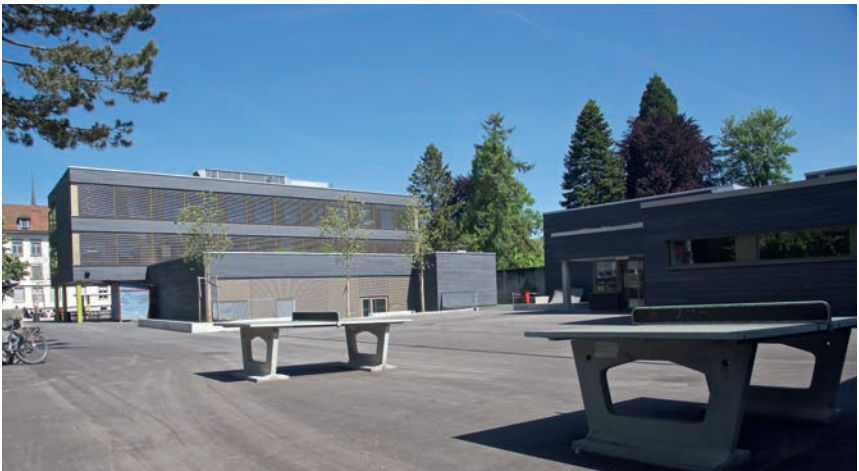
Schule Lyssbach mit dem sanierten Neubau des Kirchenfeldschulhauses
