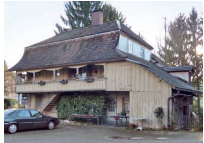
Die Ostfassade des Stöckli mit Aussentreppe
