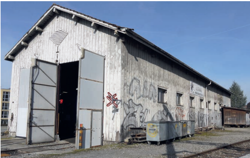
Der Lokomotivschuppen vor der Sanierung
