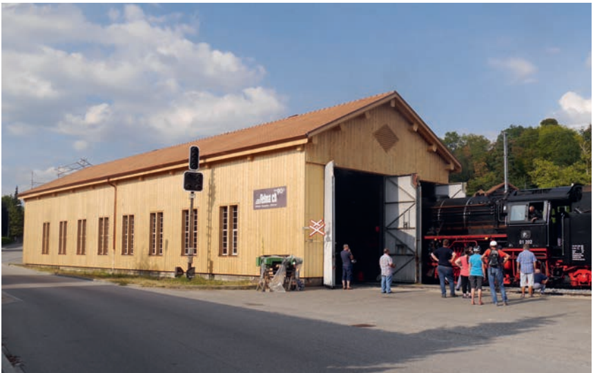
Der sanierte Lokomotivschuppen mit der Westfassade
