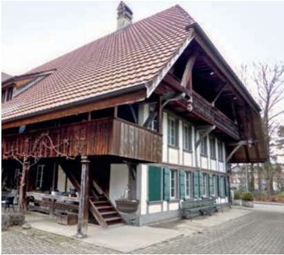
Die Hauptfassade des Bauernhauses von Süd-Westen
