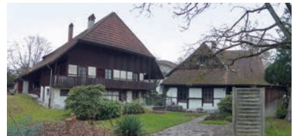
Die Ostfassade des Bauernhauses mit der Süd- fassade des Stöcklis
