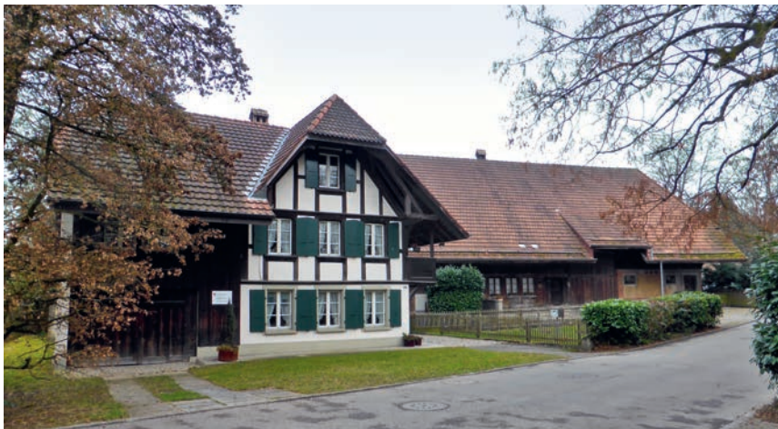
Die Kohler-Häuser mit der Hauptfassade des Stöckli
