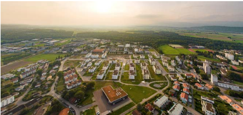
Ein neues Quartier entsteht in Lyss
