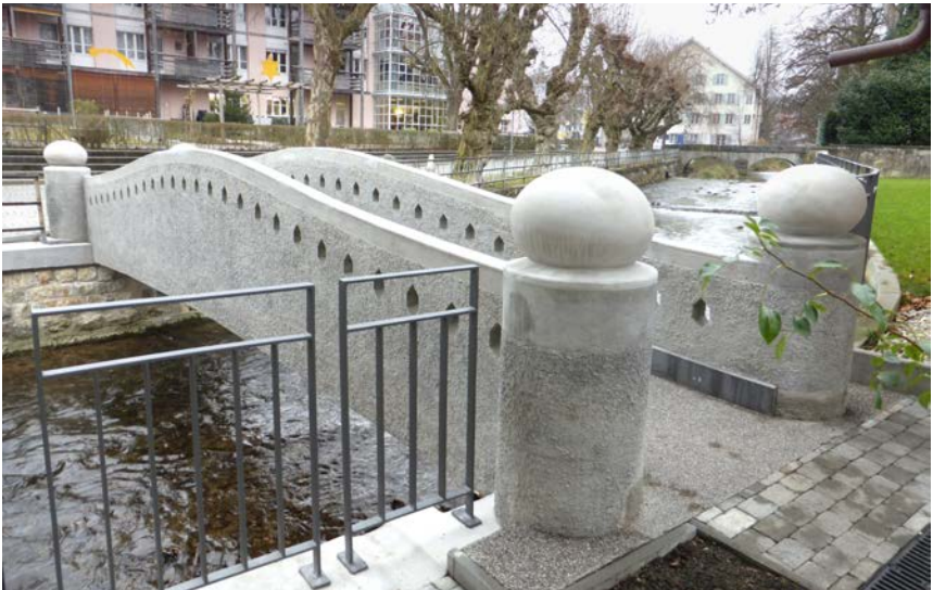
Die Brücke hinter dem Altersheim
