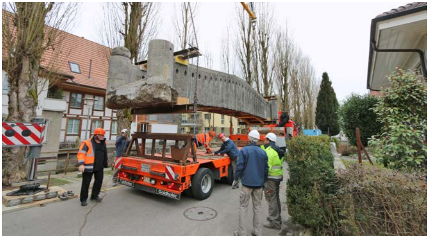
Fussweg Brücke Haus Wüthrich auf dem Weg in den «Beauty Salon»: 2016, Koordination/Bauleitung im Auftrag des Gemeindeverbands Lyssbach
