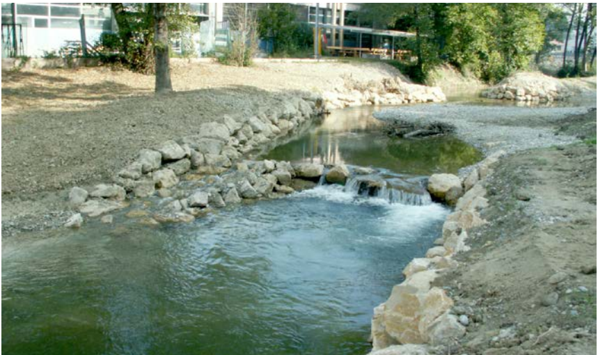
Lyssbach Schatthole nach Abschluss der Bauarbeiten, 2012
