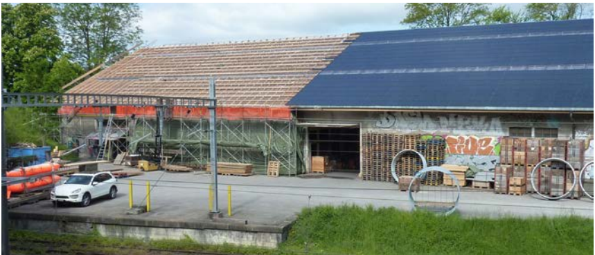
Montage der Photovoltaikanlage auf dem Heuschuppen
