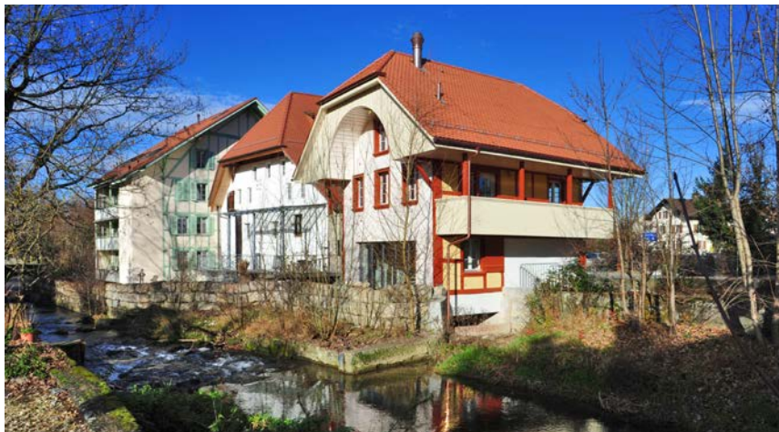
Riegbau, Mühle und Stöckli, Ansicht Seite Lyssbach, 2014
