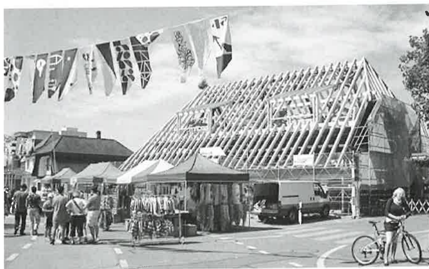
Just während des Jubiläumsjahres wurde die ehemalige «Salzbütte» restauriert.
