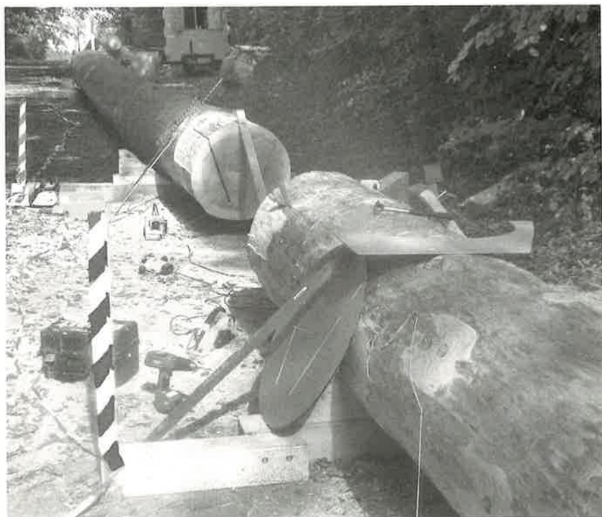
Die Douglas-Tannen mussten für den Turmbau sorgfältig vorbereitet werden.
