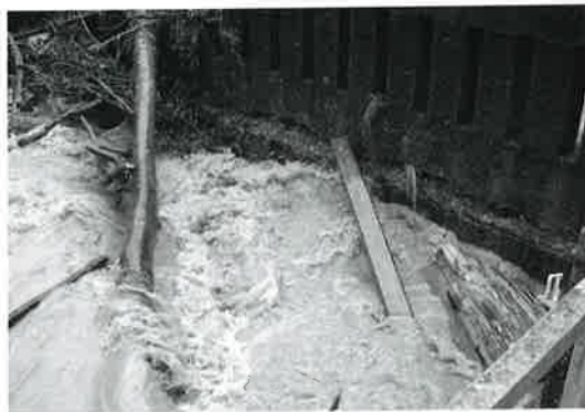
An der Brücke über den Lyssbach beim Jägerstübli blieb mitgerissenes Material hängen.
