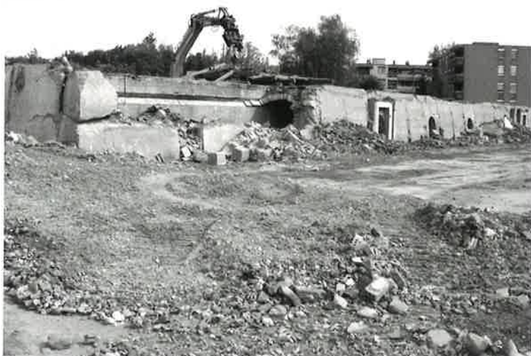
Letzte Abbrucharbeiten bei der Ziegelei
