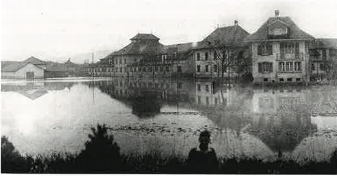
Das ganze Zeughausareal stand auch schon 1940 unter Wasser.
