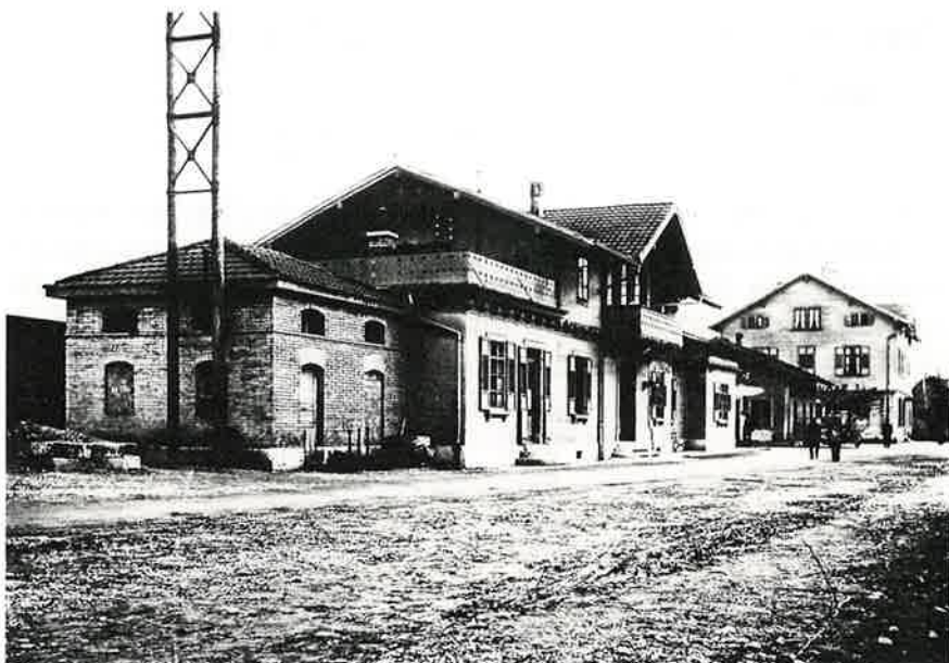
Ursprüngliches Stationsgebäude mit Anbau am noch nicht asphaltierten Bahnhofplatz.
