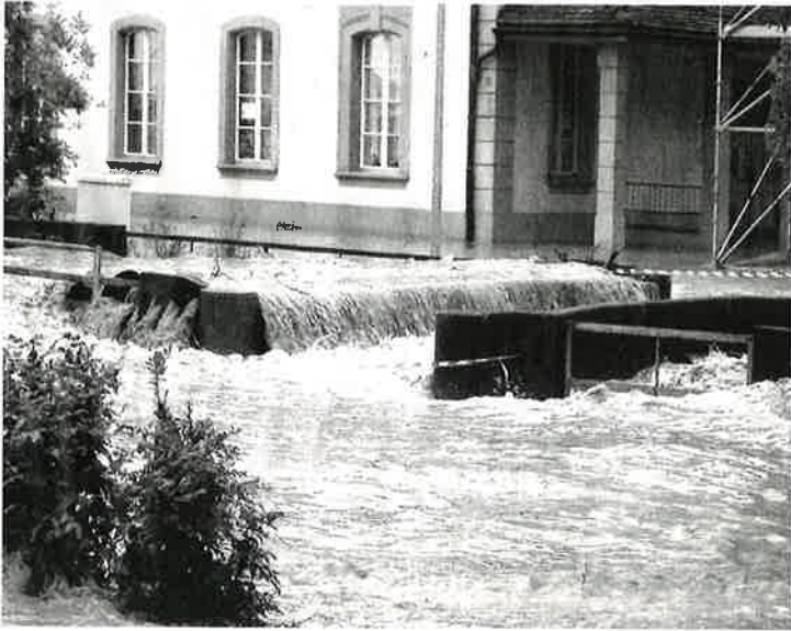
Ein furchterregendes Bild bot sich an der Lyssbachbrücke beim Schulhaus Herrengasse.
