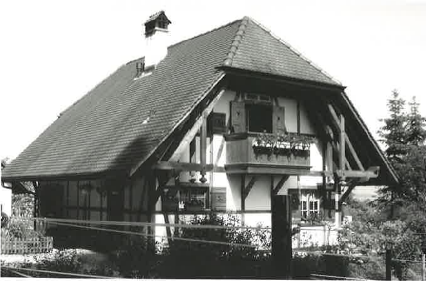
Speicher an der Gemeindegrenze im «Eigenacker»
