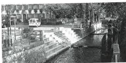
Lyssbachtreppe beim Weissen Kreuz
