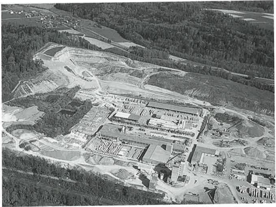
Neubauten Bangerter-Grube/Creábeton (links oben: Hardern)
