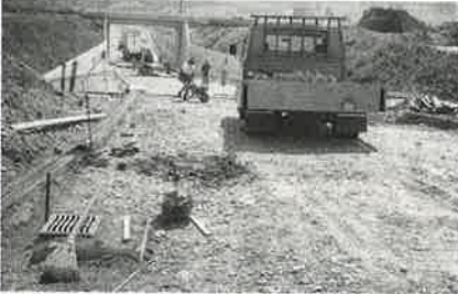
Austrasse (Zufahrt Industrie Süd)
