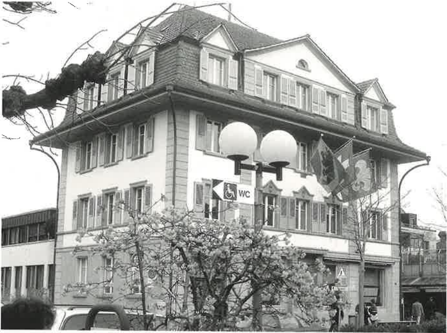
Umgebautes Gemeindehaus mit neuem Anbau Juraweg
