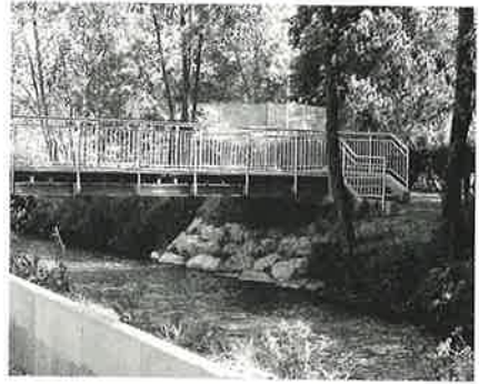
Neue Lyssbachbrücke Schönau
