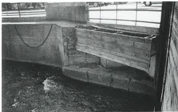
Der noch vorhandene Oberwasser-Einlauf am linken Ufer des Lyssbachs
