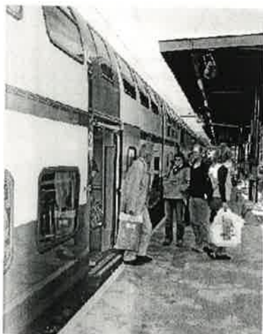
Die neuen Perronanlagen auf dem Bahnhof
