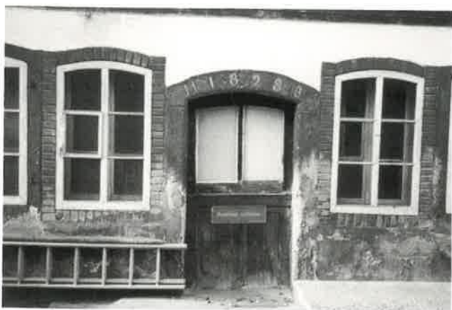
Die Eingangstüre des 1828 erstellten Hauptgebäudes
