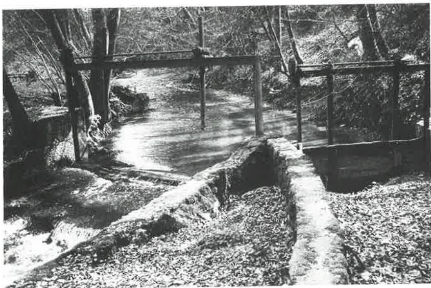
Pritsche im Lyssbach und Einlauf Oberwasserkanal
