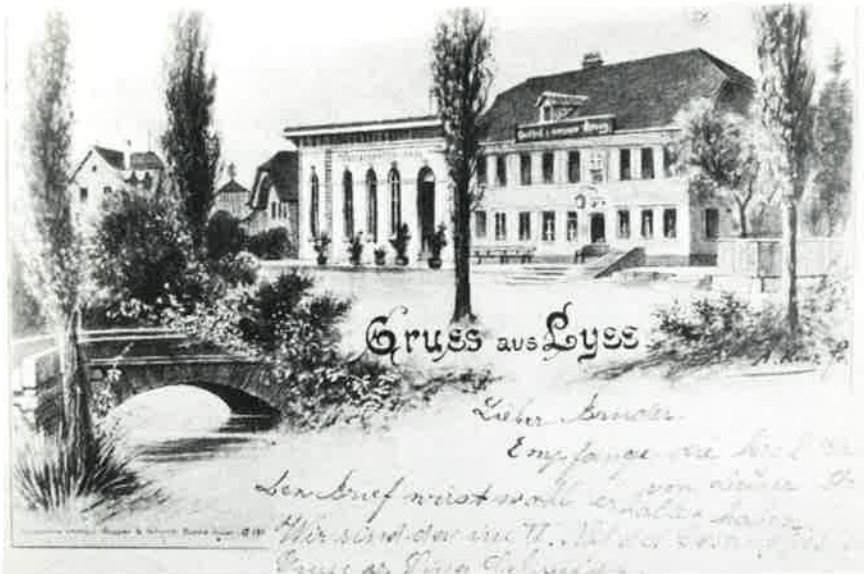
Zustand nach dem Saalbau (ca. 1903), Brücke über den Schlattbach
