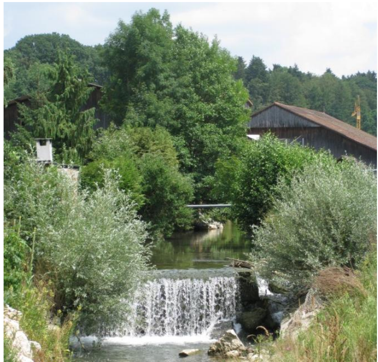
Alte Wehranlage bei der Leen-Mühle, die im Rahmen des Hochwasserschutzprojektes eliminiert wird. So wird für aufsteigende Wasserorganismen der Weg zu weiteren 3.5 km Lyssbach frei gemacht.
