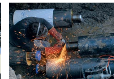
Für den Wärmeverbund müssen Fernwärmeleitungen verlegt werden.
