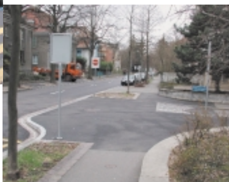
Das durchgezogene Trottoir schafft klare Vortrittsverhältnisse und bedeutet insbesondere für ältere oder gehbehinderte FussgängerInnen einen Komfortgewinn.
